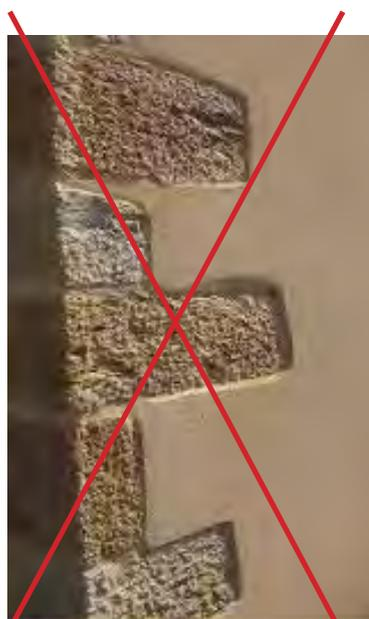
**ENDUIT** mise en oeuvre interdite, l'enduit doit être affleurant à la modénature ou celle-ci doit être saillante par rapport à l'enduit
