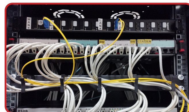
Réalisation complète réseau trait d'union
